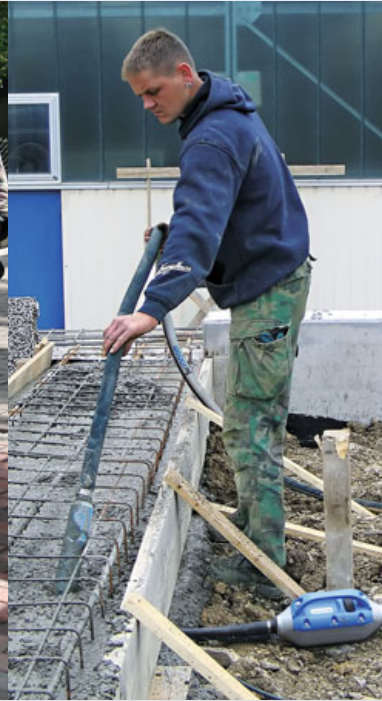
Bewährt im Baustellenalltag: Bodenverdichter CR 3 und IVUR-Innenvibrator.
